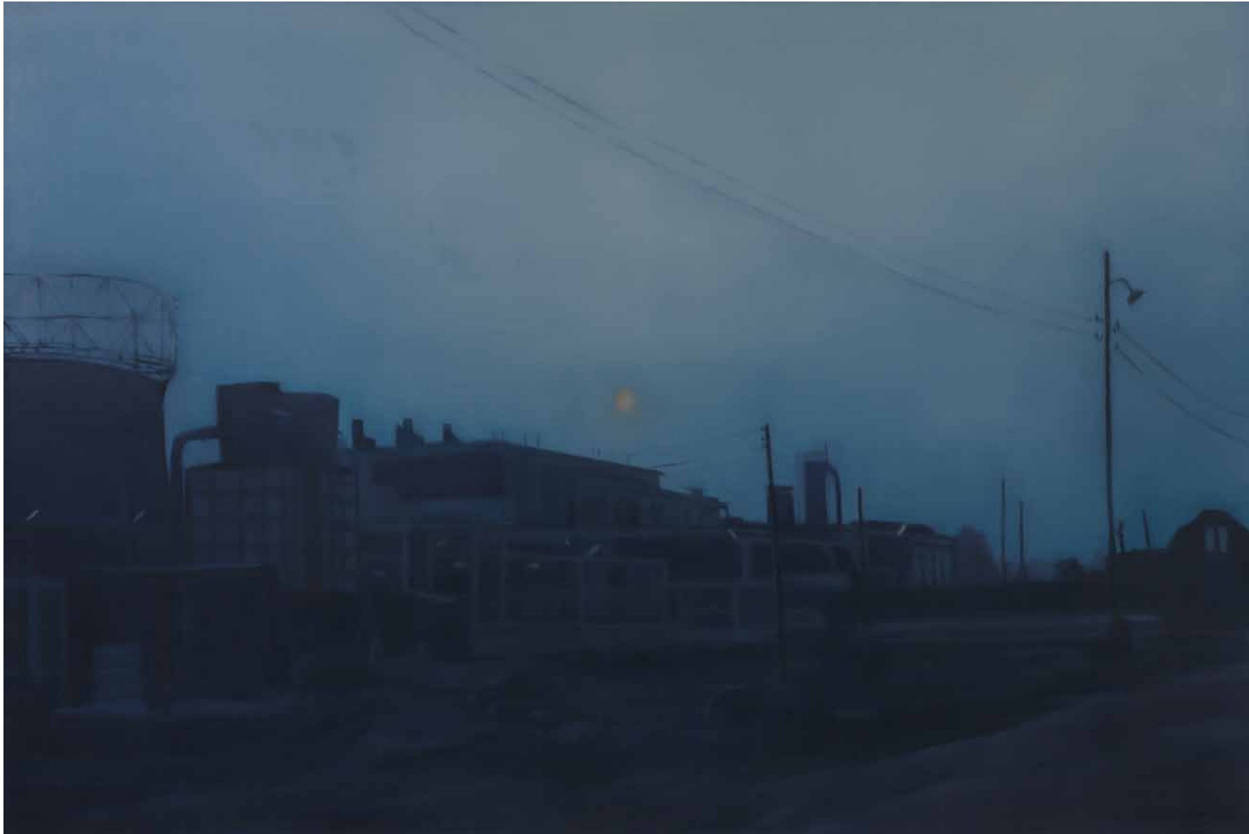
Stahlwerk / Aciérie / Steelworks
